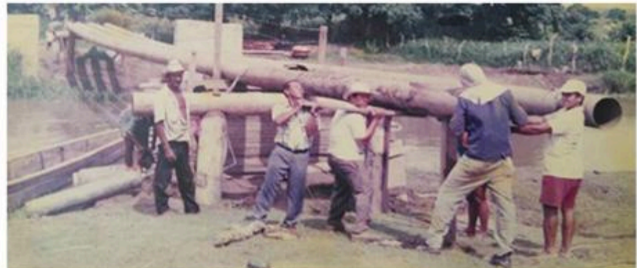
Ayudando a construir el puente sobre El Chorro en el camino a Madrid.
